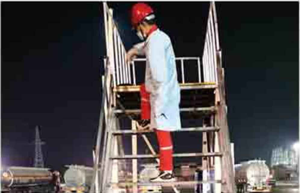
近日，运营服务部外检员在监督司机取样过程中，发现取样平台上方护栏以及楼梯护栏扶手等多处出现生锈，如果不及时处理，一旦平台大面积生锈，将产生设备损害安全隐患。
